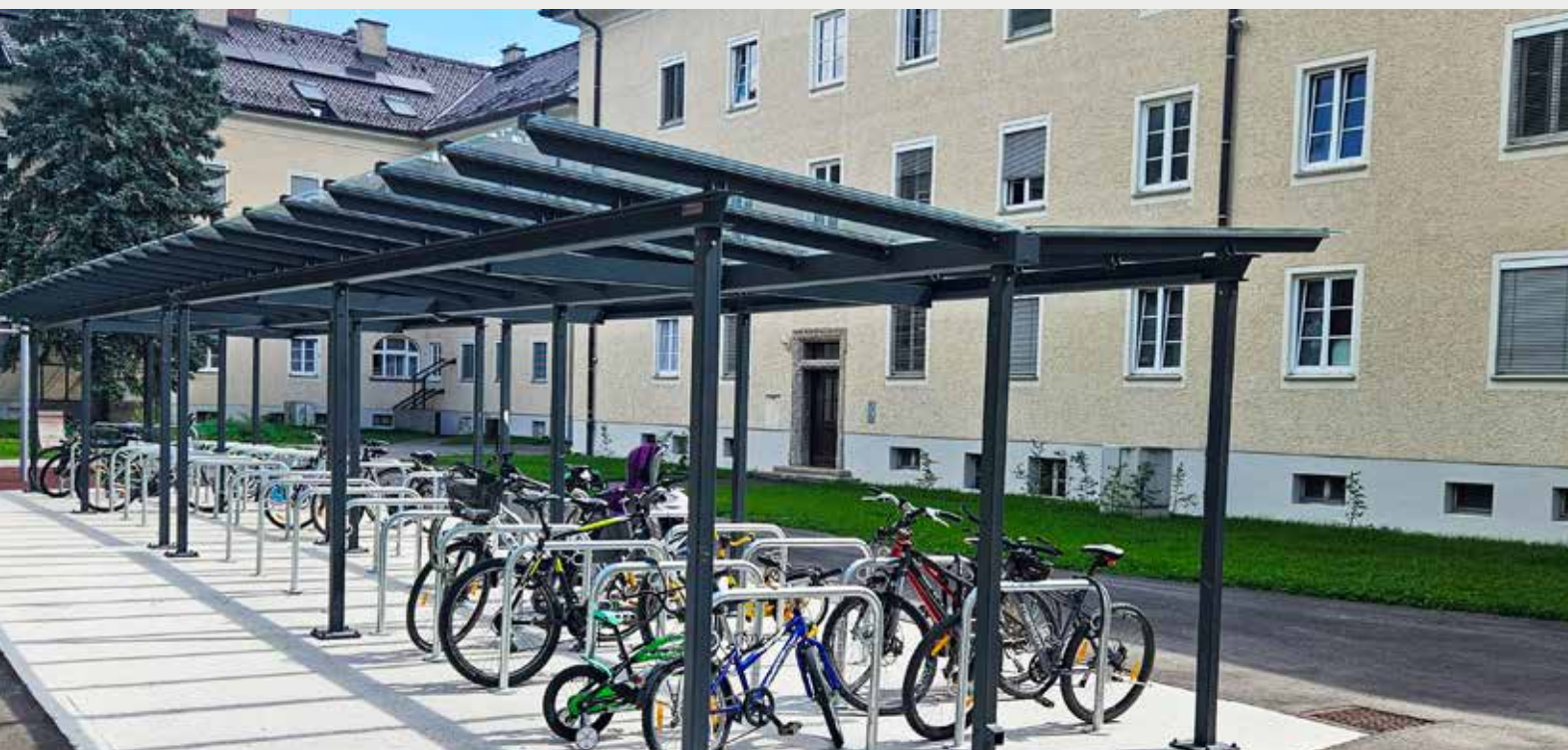
Neue überdachte Fahrradabstellflächen im Leheiner Vierkanter
